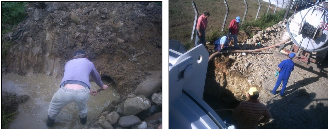
Figura 3: Serviços de manutenção da rede de drenagem sendo executados (Fonte: Sec. de Obras).
