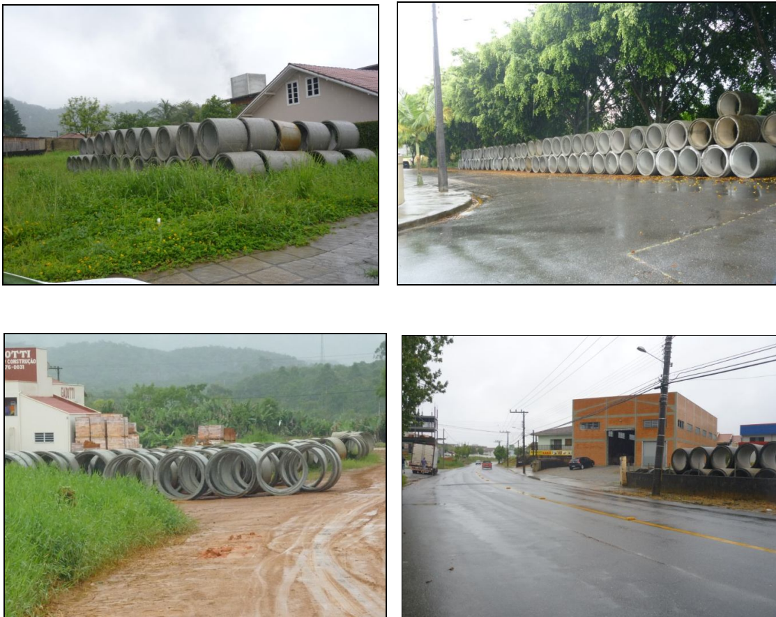
Figura 13: Tubos alocados próximo aos locais onde serão executadas obras de drenagem (Foto: Dezembro/ 2010).
